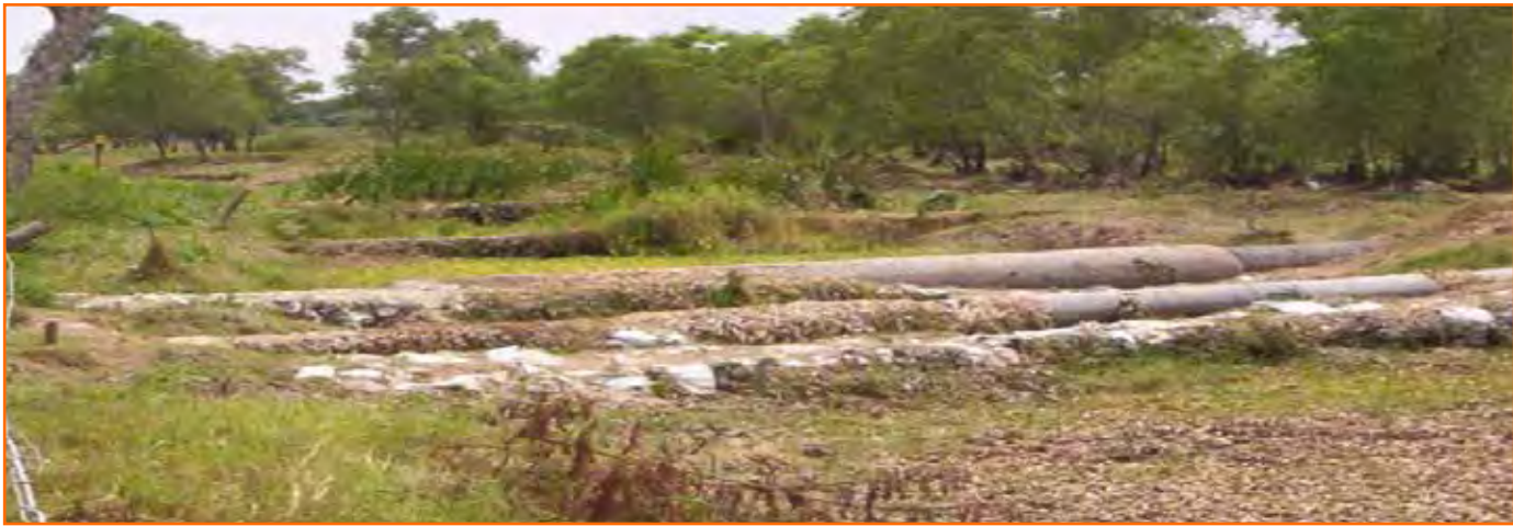
Ductos de PEMEX formando un tapón por la basura y vegetación retenida. Fotografía: CENAPRED, 2008.
