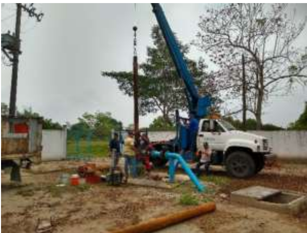
Instalación de equipo de bombeo.
