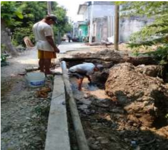
Reparación de línea de distribución.
