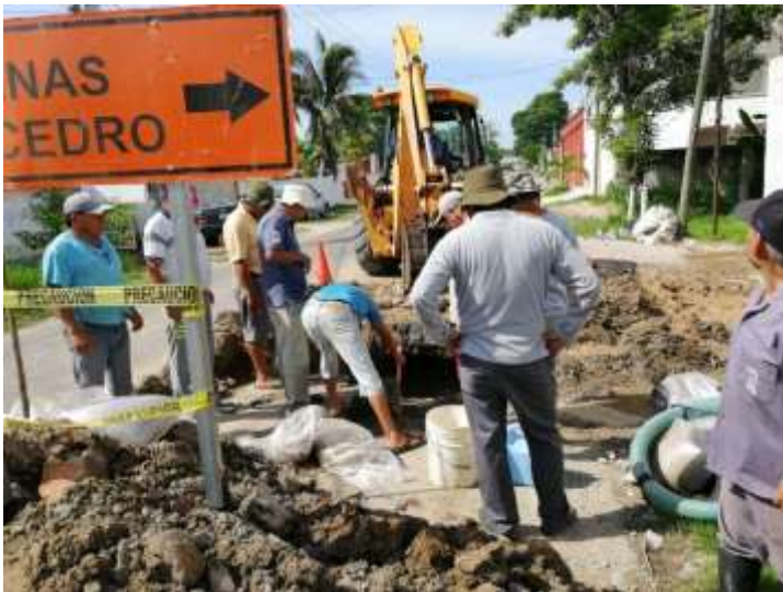
Reparación de fuga de agua potable.
