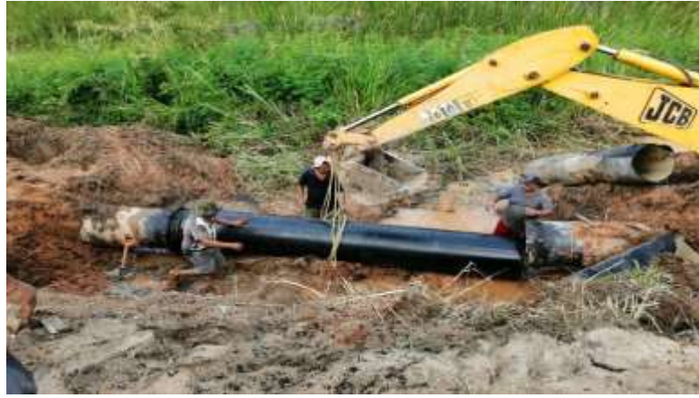
Reparación de línea de conducción de 26" de diámetro.
