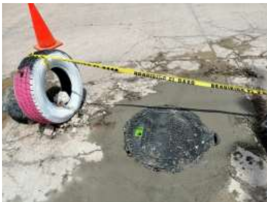
Instalación de tapa para pozo de visita.
