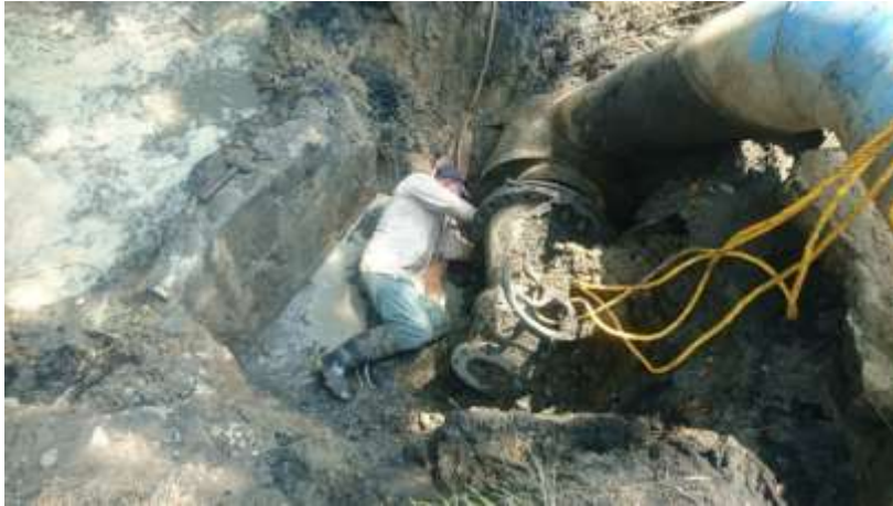
Reparación de línea de presión.
