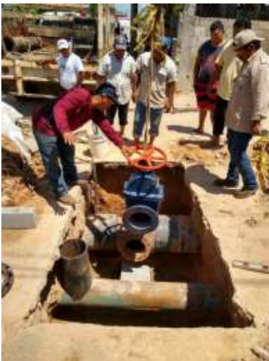
Colocación de válvula tipo compuerta.
