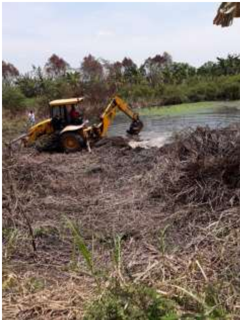
Modificación de red de alcantarillado sanitario.
