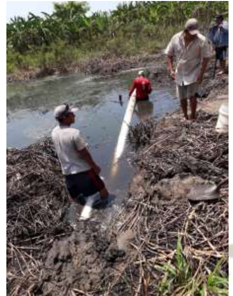
Línea sanitaria de 8" de PVC.
