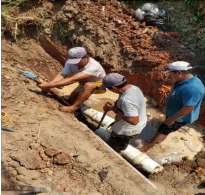
Reparación de fuga en línea.
