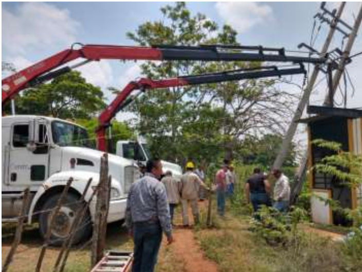
Instalación de transformador en captación de la Planta Potabilizadora Pueblo Nuevo.
