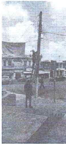
Foto. -1 Reparación de cables cortados Parque José Gorostiza
