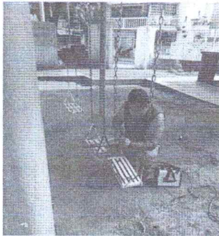
Foto. -5 Reparación de columpios del parque Sueños y Deseos
