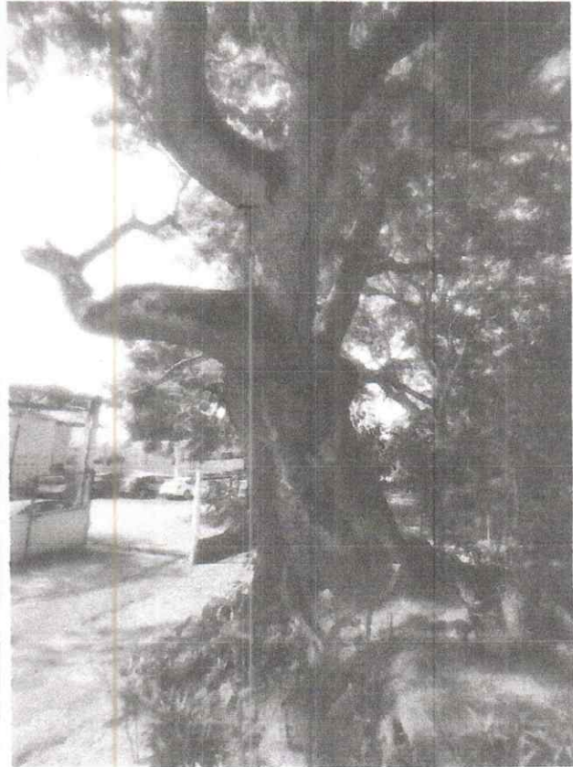
Foto 2. Se logra observar segunda especie de Guanacaste con inclinación hacia la instalación.
