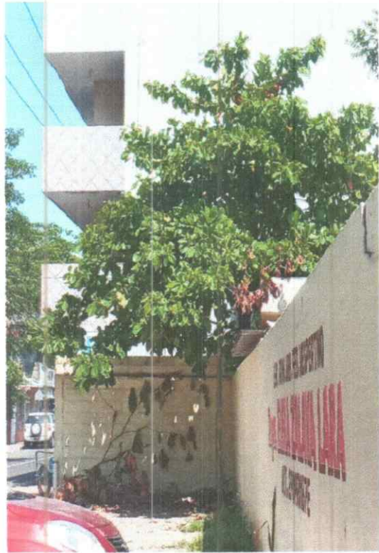
Foto 2. Se aprecia ramas de la especie obstruyendo el cableado eléctrico.
