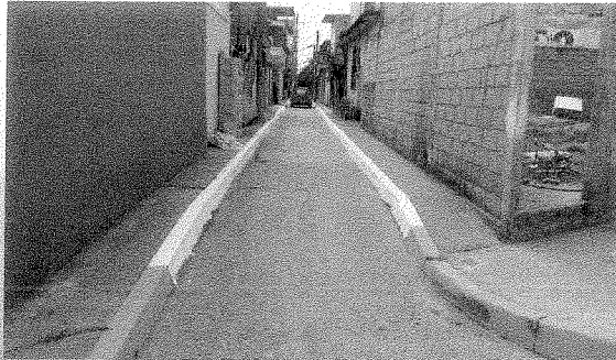
Limpieza y pintado de guarniciones en 24 calles y 5 callejones
