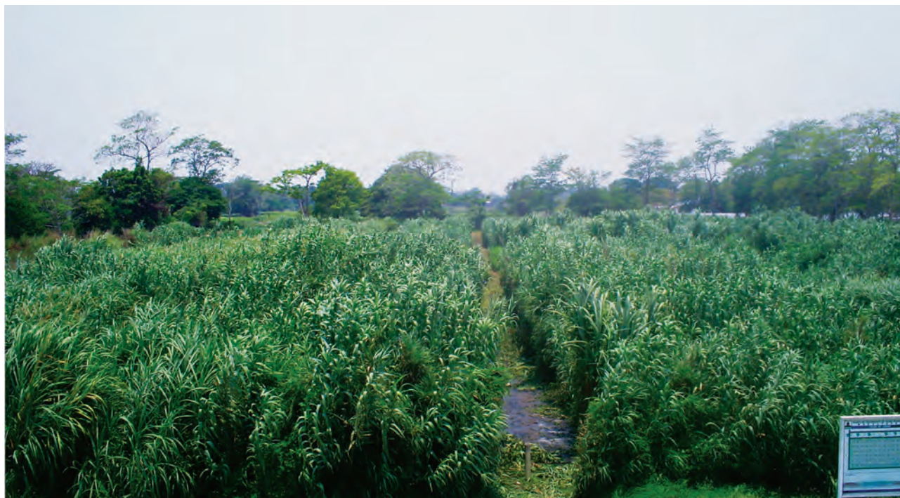
Pantanos artificiales. Tratamiento de aguas residuales en Macultepec.
